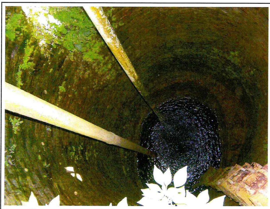
Φωτ. 2: Διάθεση νερού εμπλουτισμού σε φρέαρ μέσω της στήλης του αντλητικού συγκροτήματος
