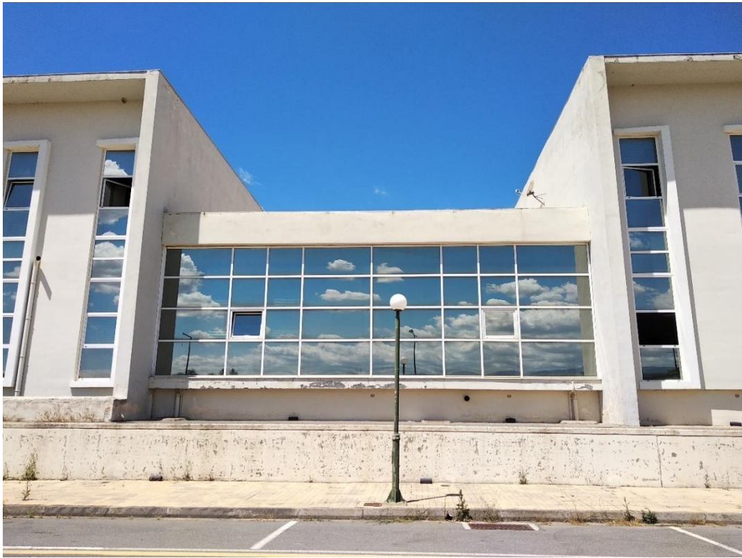
Εικόνα 34 Ανατολική όψη τμήμα ενδιαμέσο
