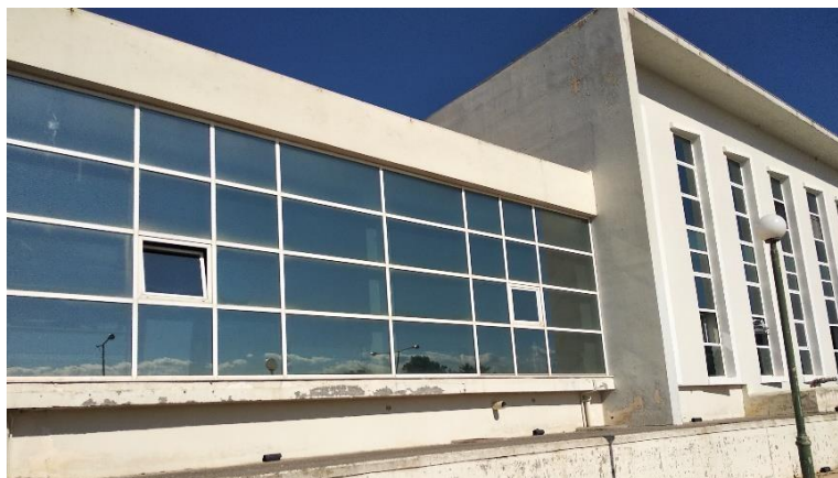
Εικόνα 50 Κουφώματα του κτιρίου
