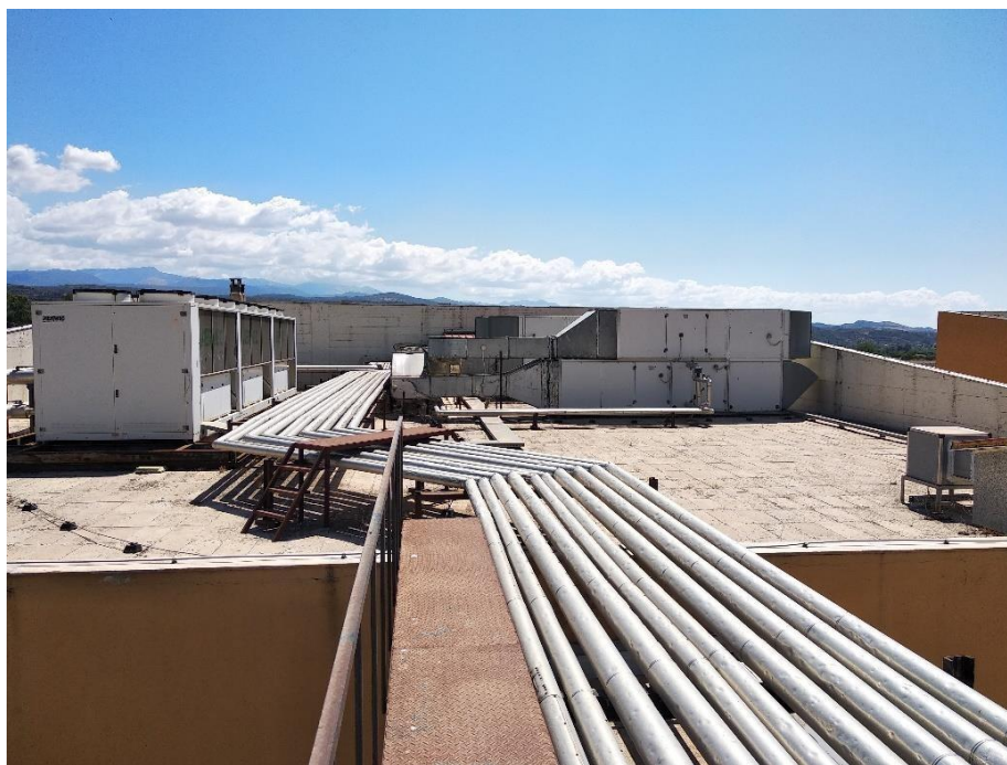
Εικόνα 74 Οι ΚΚΜ στο κτίριο
