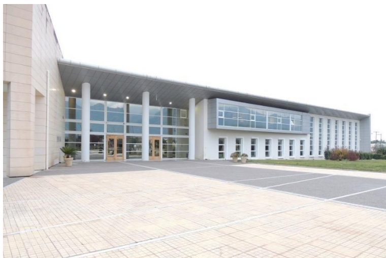
Εικόνα 7 Το προς επιθεώρηση κτίριο: Το Διοικητήριο Σπάρτης
