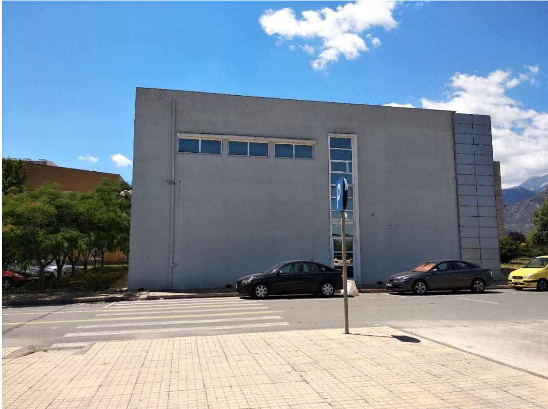
Εικόνα 40 Βόρεια όψη τμήμα Ι
