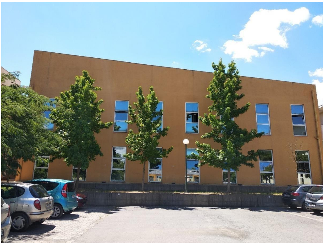
Εικόνα 41 Βόρεια όψη τμήμα ΙΙΙ
