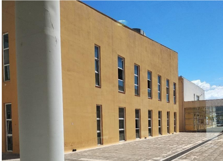
Εικόνα 51 Κουφώματα του κτιρίου
