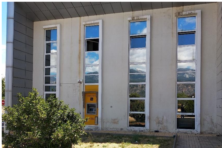
Εικόνα 47 Κουφώματα του κτιρίου
