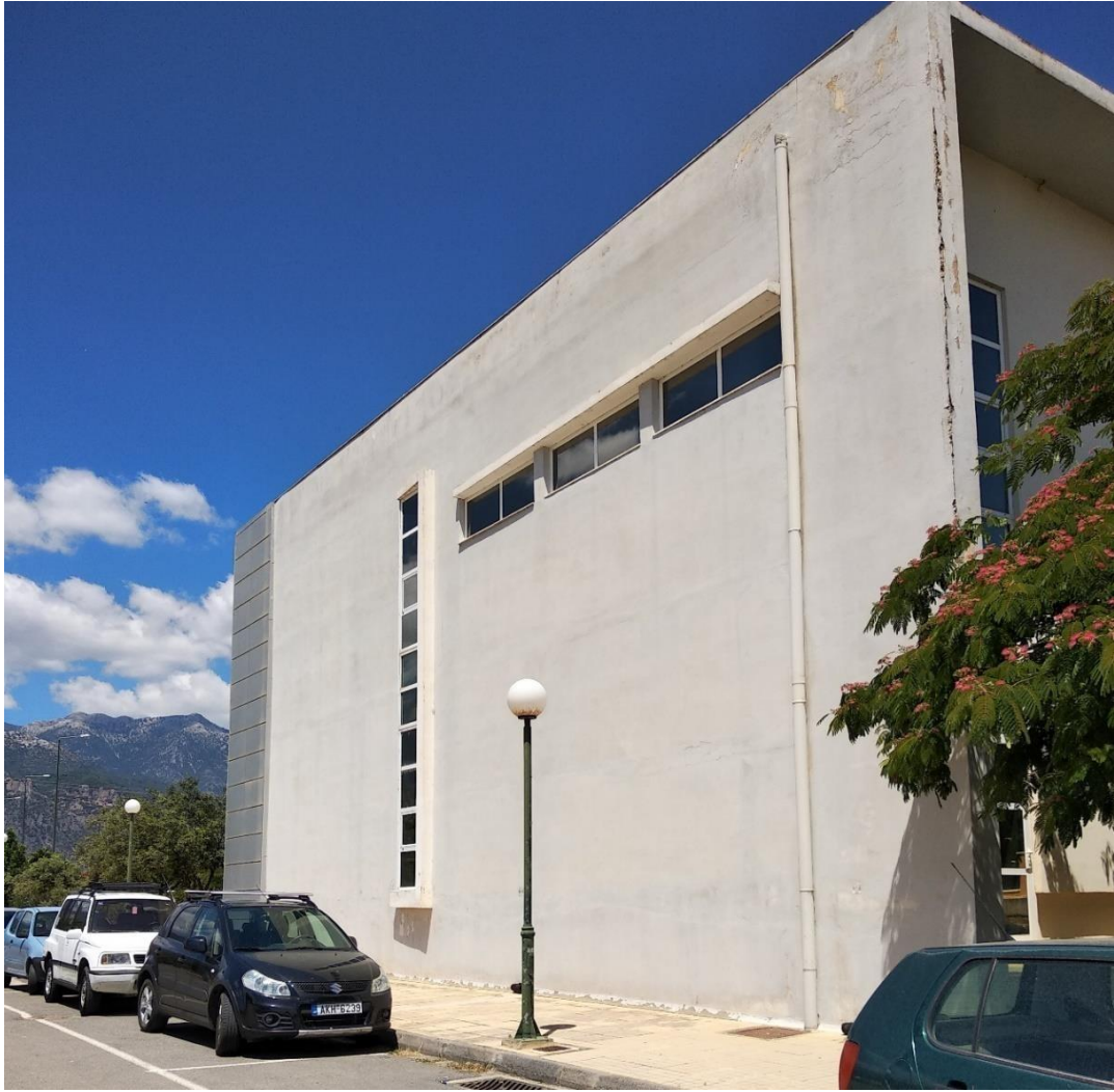
Εικόνα 43 Νότια όψη τμήμα ΙΙ
