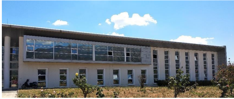
Εικόνα 48 Κουφώματα του κτιρίου
