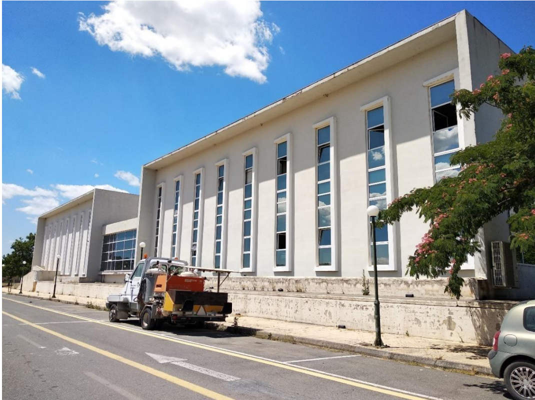
Εικόνα 32 Ανατολική όψη κτιρίου
