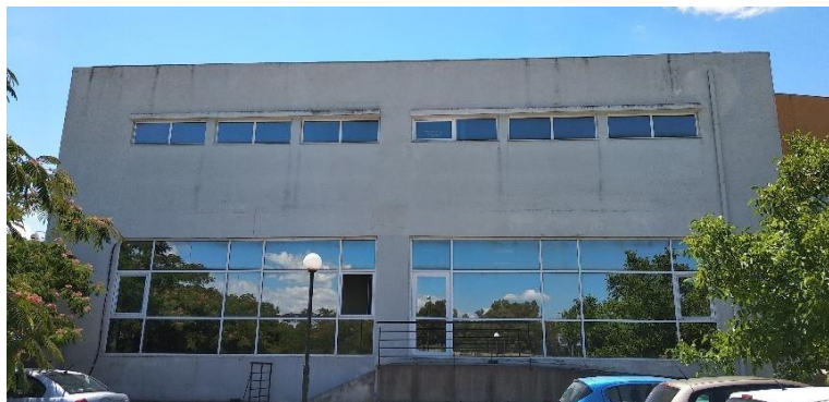
Εικόνα 49 Κουφώματα του κτιρίου
