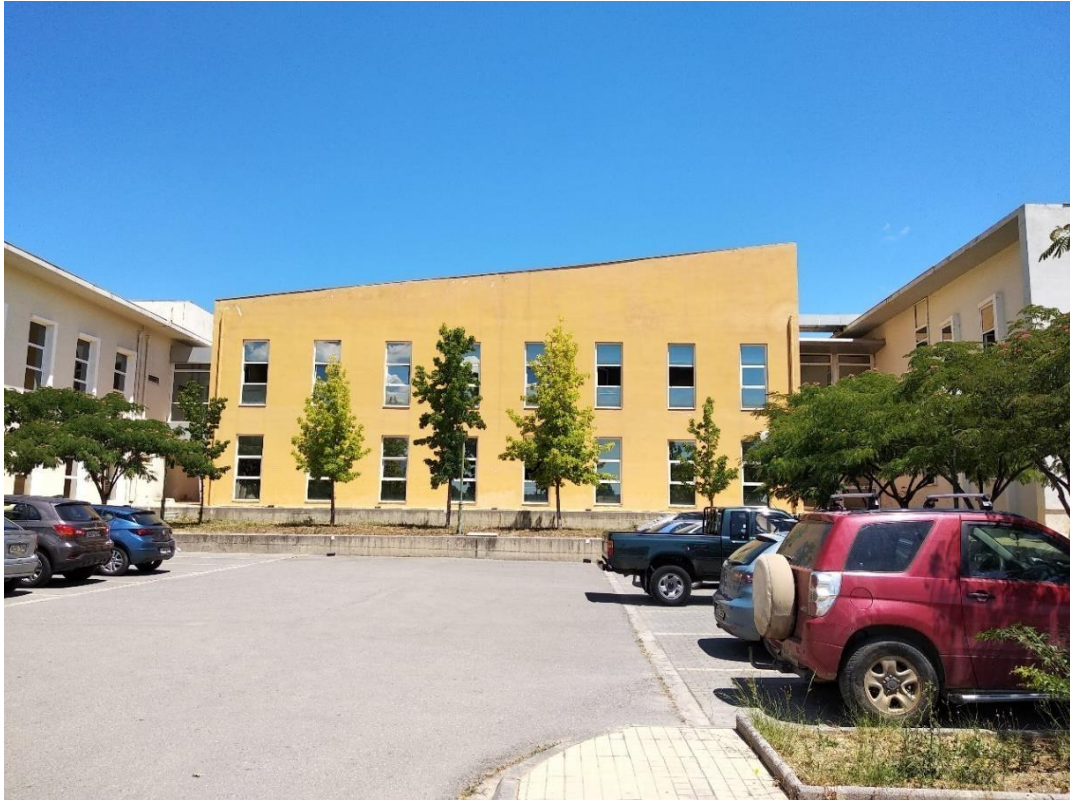
Εικόνα 44 Νότια όψη τμήμα ΙΙΙ
