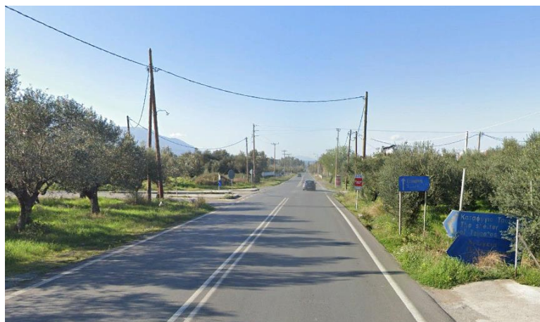
Ι.Κ. 2: Ενδεικτικές φωτογραφίες από τον Ισόπεδο Κόμβο προς Ανώγεια
