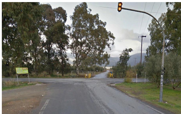
Ι.Κ. 7: Ενδεικτικές φωτογραφίες από τον Ισόπεδο Κόμβο προς Παπαδιάνικα
