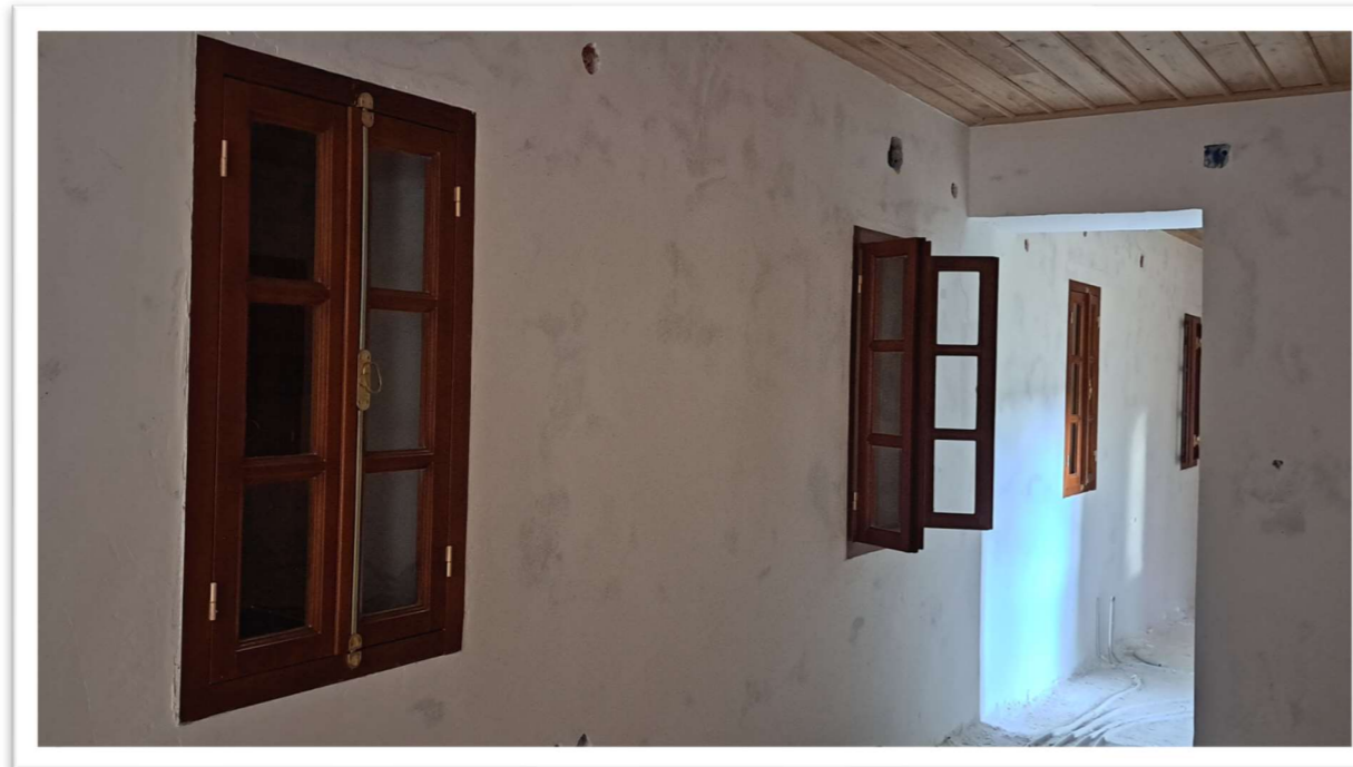
11/2023 | Κατασκευή Ξύλινων Κουφωμάτων
