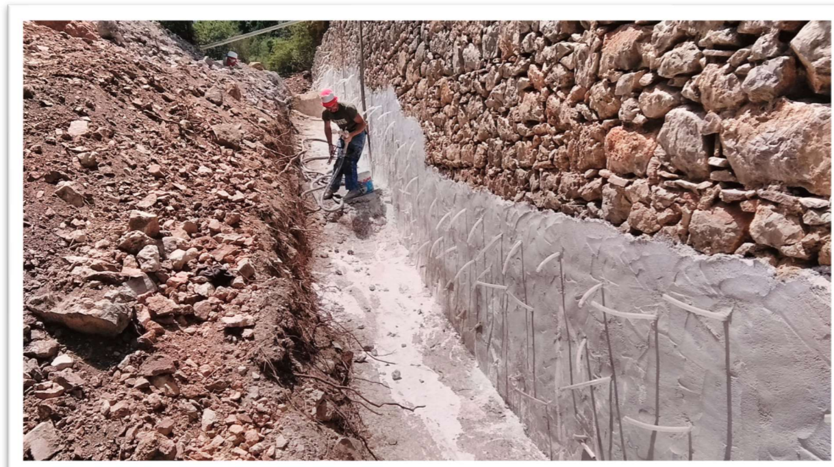
07/2021 | Εφαρμογή Ενεμάτων Λιθοδομών
