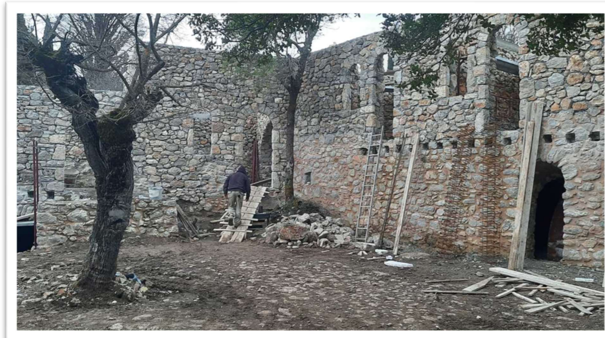
04/2022 | Κατασκευή - Αναδόμηση Λιθοδομών
