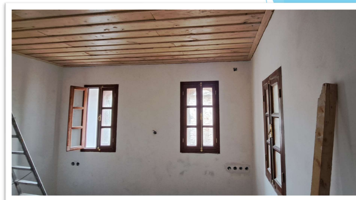
12/2023 | Κατασκευή Ξύλινων Οροφών - Η/Μ
