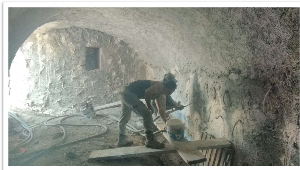
08/2021 | Εφαρμογή Ενεμάτων Λιθοδομών
