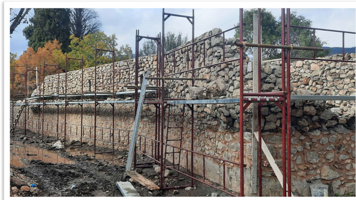
12/2021 | Κατασκευή - Αναδόμηση Λιθοδομών
