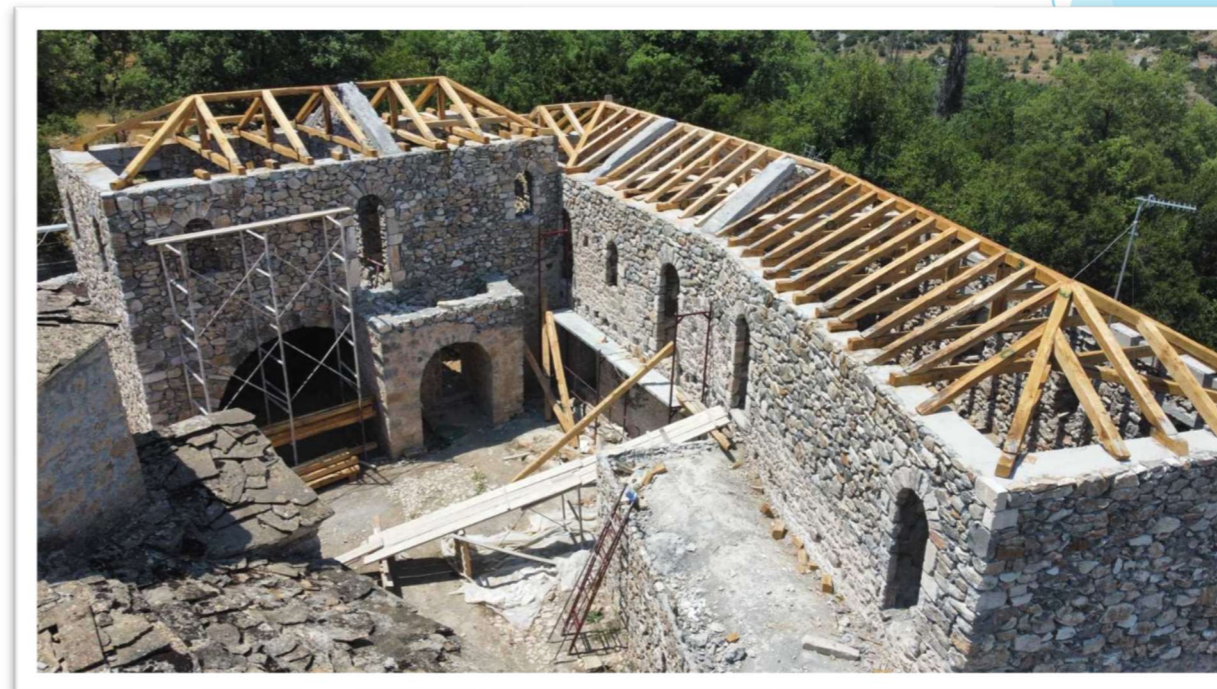
06/2022 | Κατασκευή Φ.Ο. Ξύλινων Στεγών
