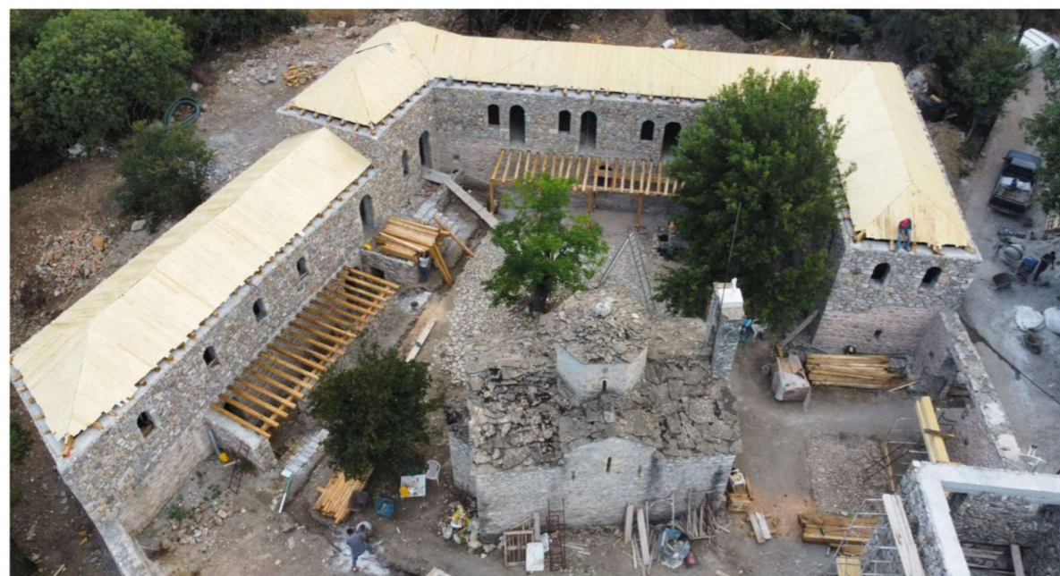
07/2022 | Ξύλινες Κατασκευές - Επιστεγάσεις
