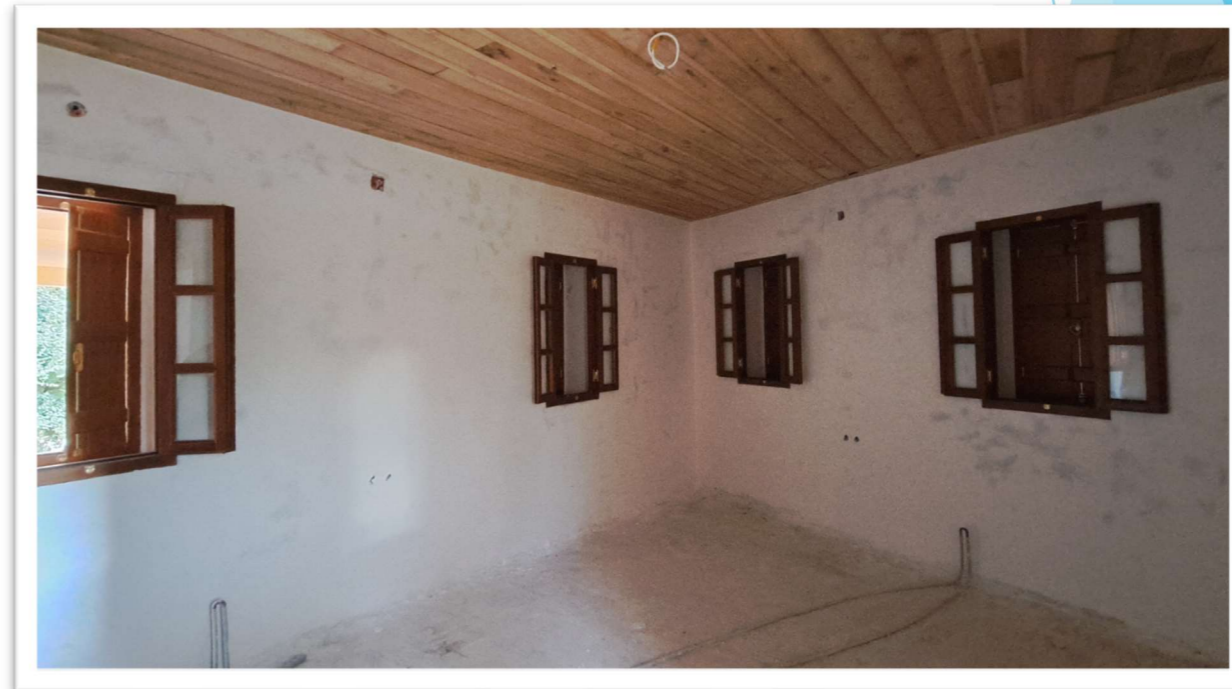
11/2023 | Κατασκευή Ξύλινων Κουφωμάτων
