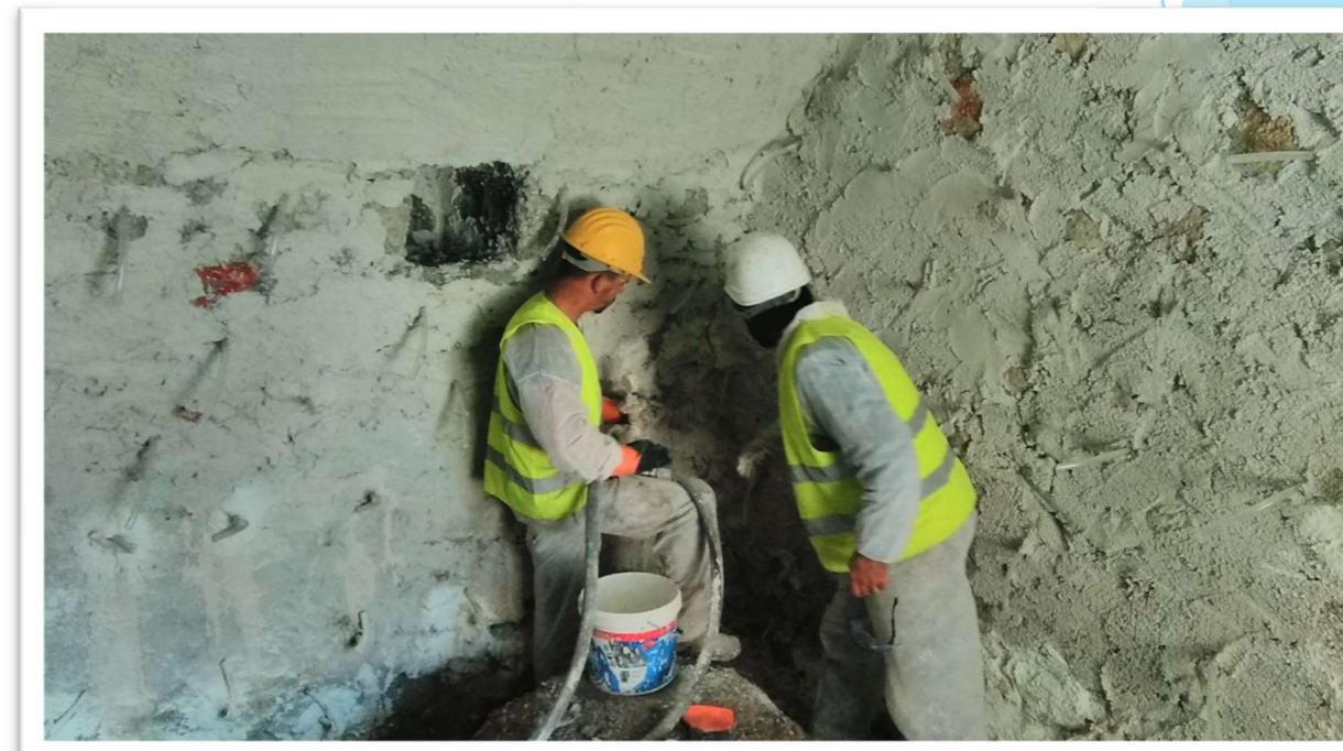
07/2021 | Εφαρμογή Ενεμάτων Λιθοδομών
