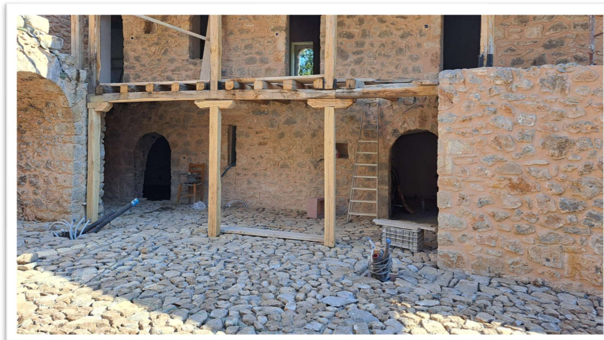
05/2023 | Κατασκευή Εξωτερικού Λιθόστρωτου
