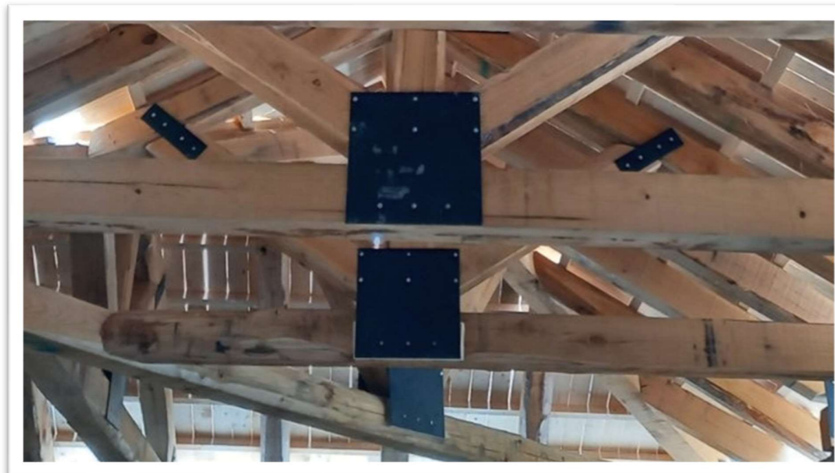
06/2022 | Κατασκευή Ξύλινων Στεγών
