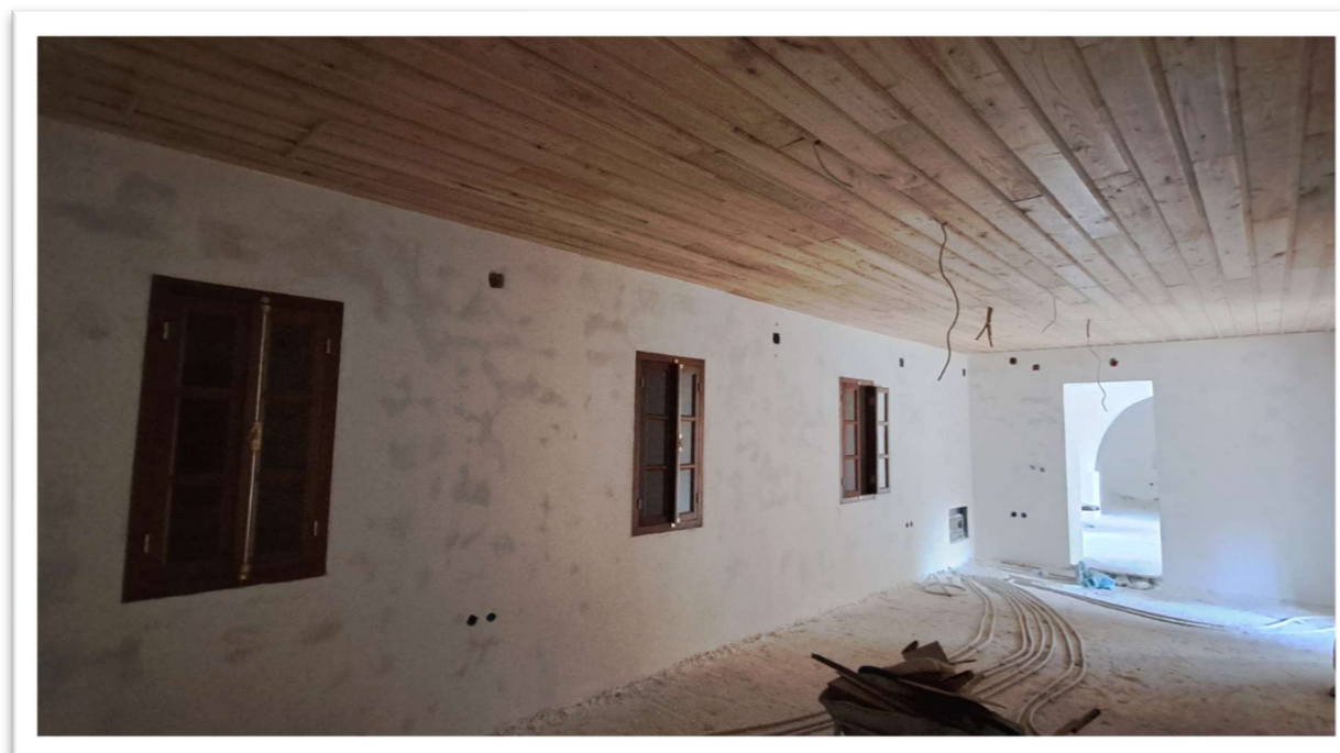
12/2023 | Κατασκευή Ξύλινων Οροφών - Η/Μ
