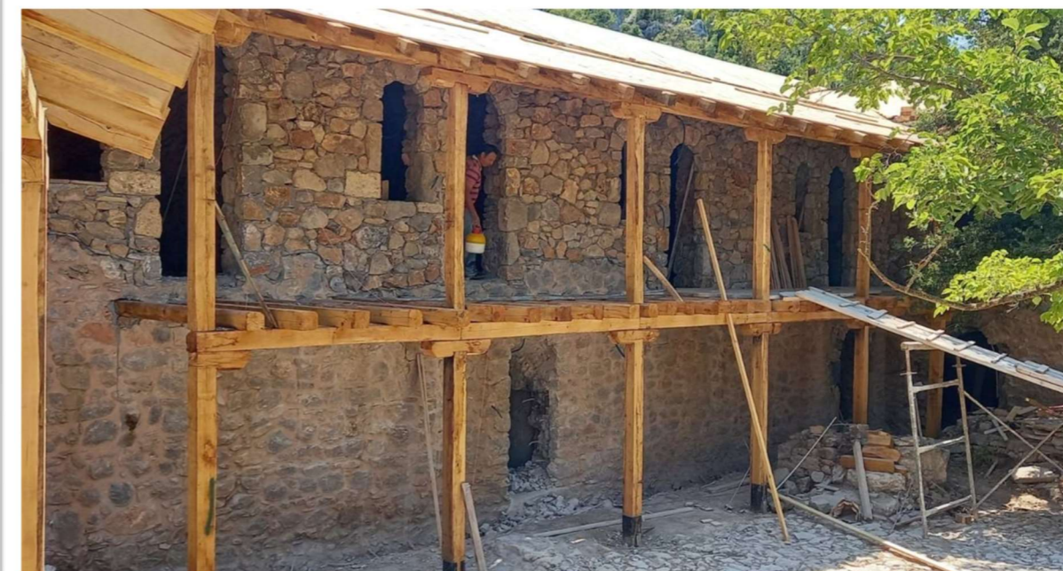
07/2022 | Ξύλινες Κατασκευές - Επιστεγάσεις
