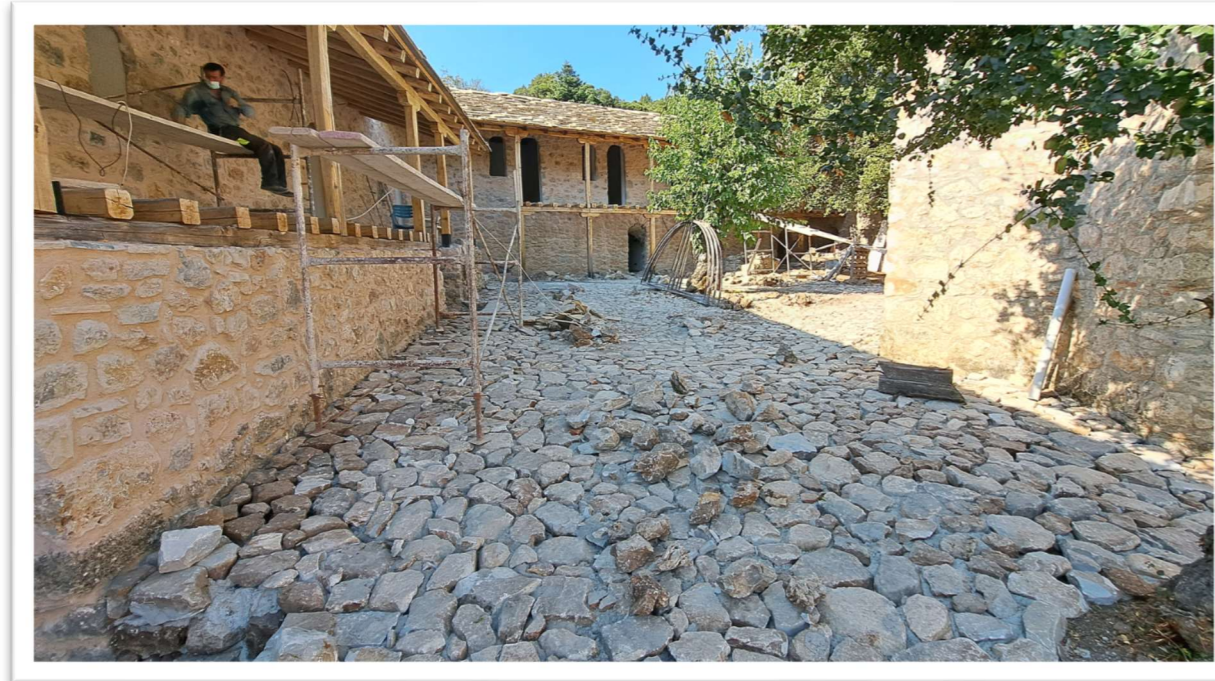
10/2023 | Κατασκευή Εξωτερικού Λιθόστρωτου
