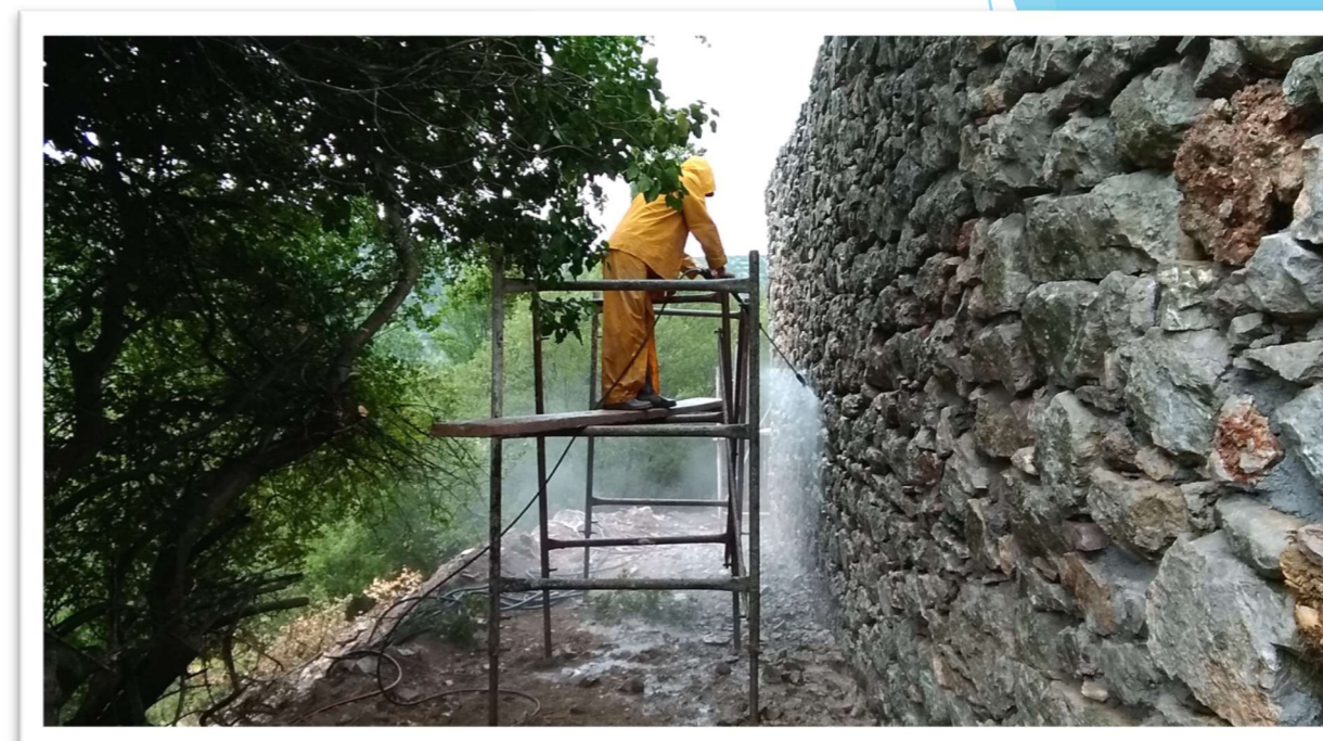
06/2021 | Καθαρισμός Λιθοδομών - Υδροβολή
