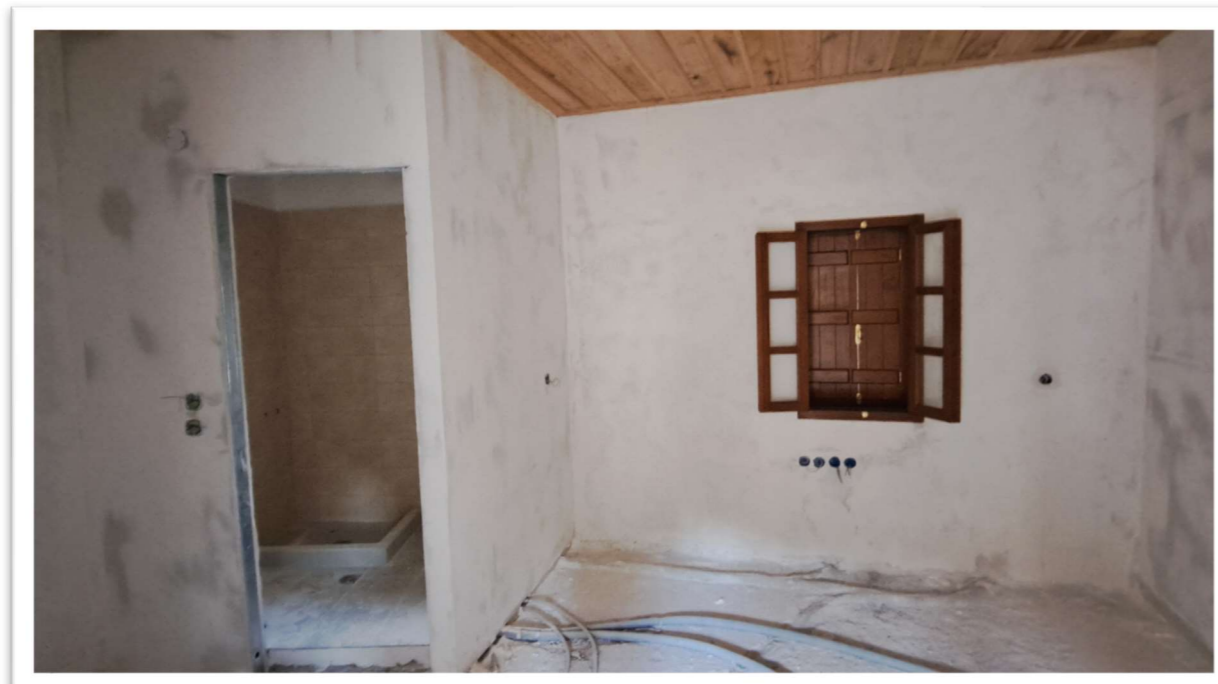
12/2023 | Κατασκευή Χώρων W.C. - Η/Μ Οδεύσεις
