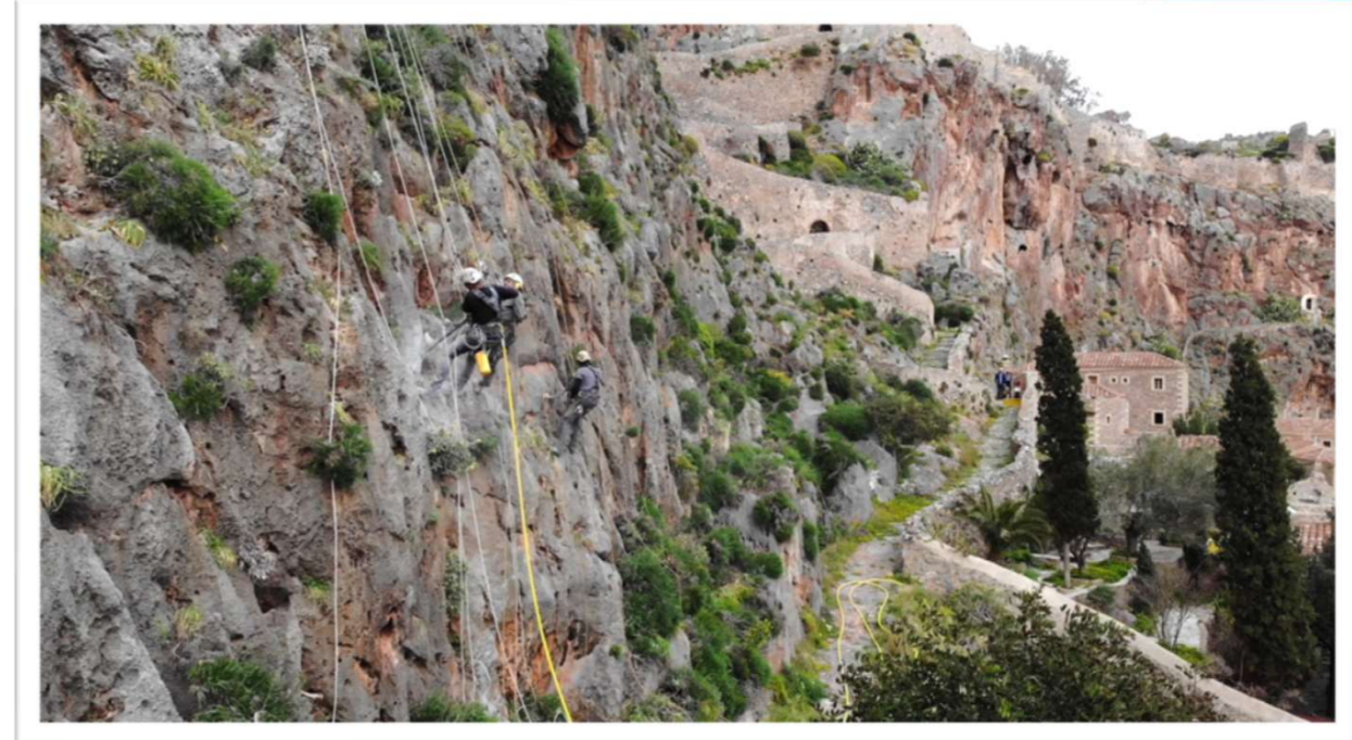
03/2022 | Διατρήσεις βράχων - εγκατάσταση αγκυριών
