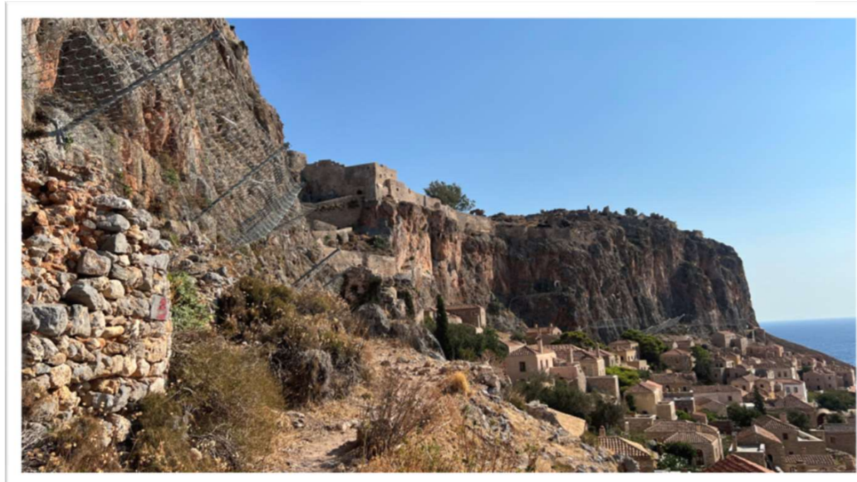
06/2023 | Ολοκλήρωση εργασιών σταθεροποίησης βραχωδών πρανών
