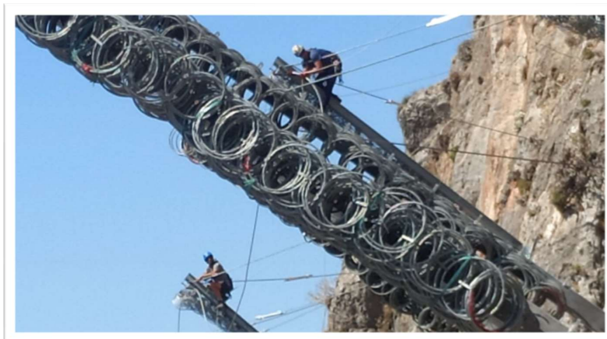
06/2022 | Εγκατάσταση φραχτών ανάσχεσης
