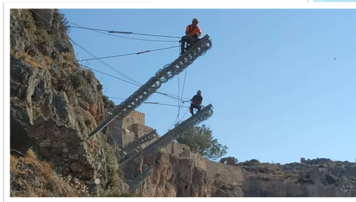
06/2022 | Εγκατάσταση φραχτών ανάσχεσης
