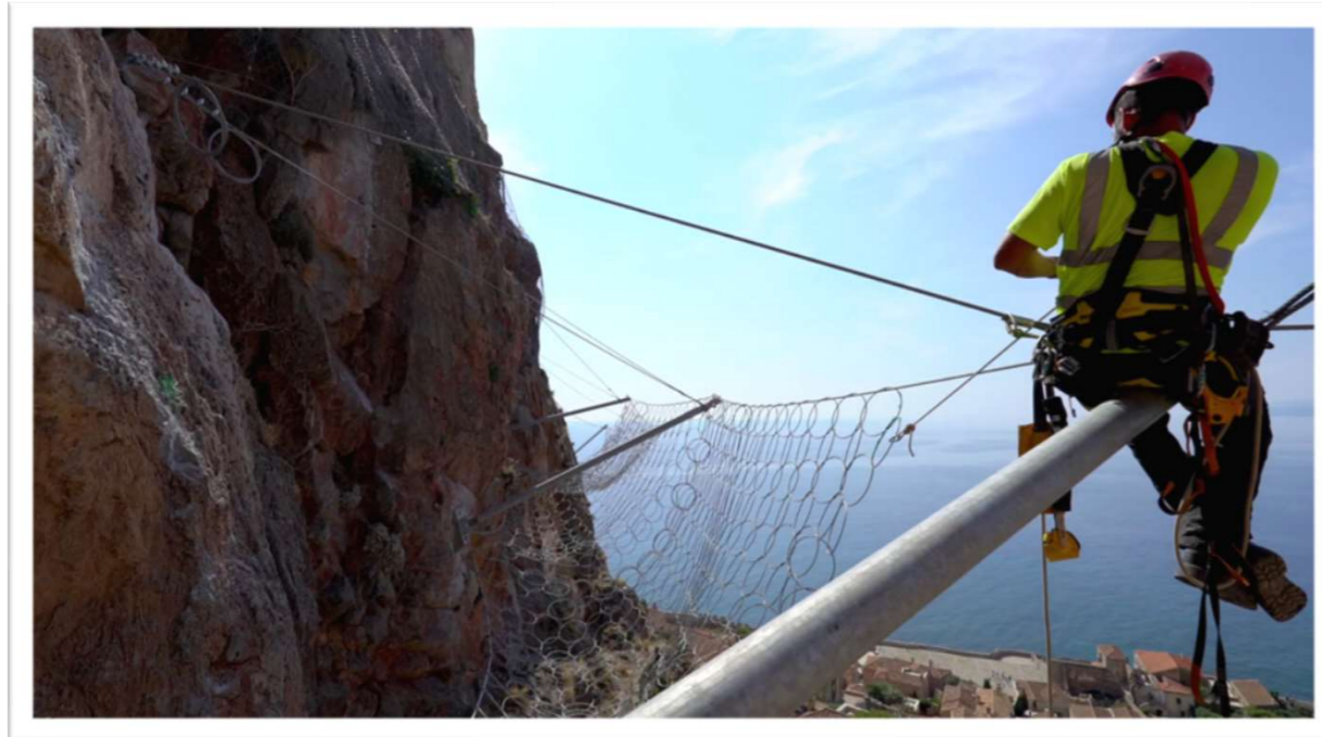
06/2023 | Ανάρτηση - Τάνυση πλέγματος φραχτών ανάσχεσης
