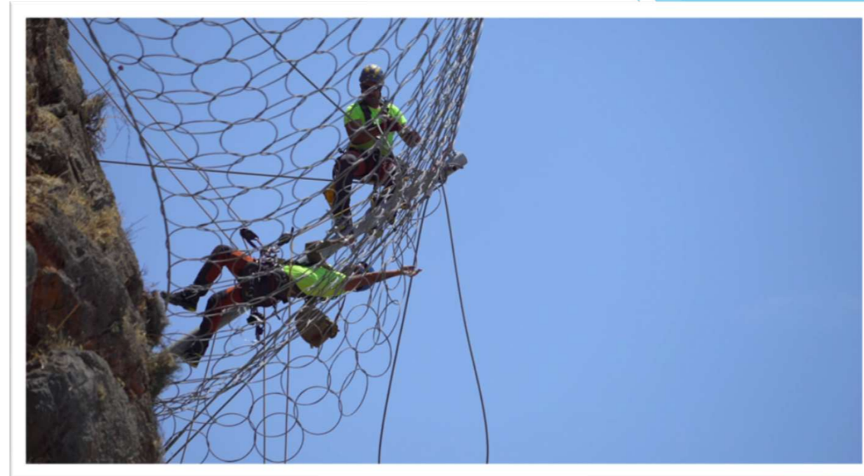
06/2023 | Εγκατάσταση πλεγμάτων φραχτών ανάσχεσης
