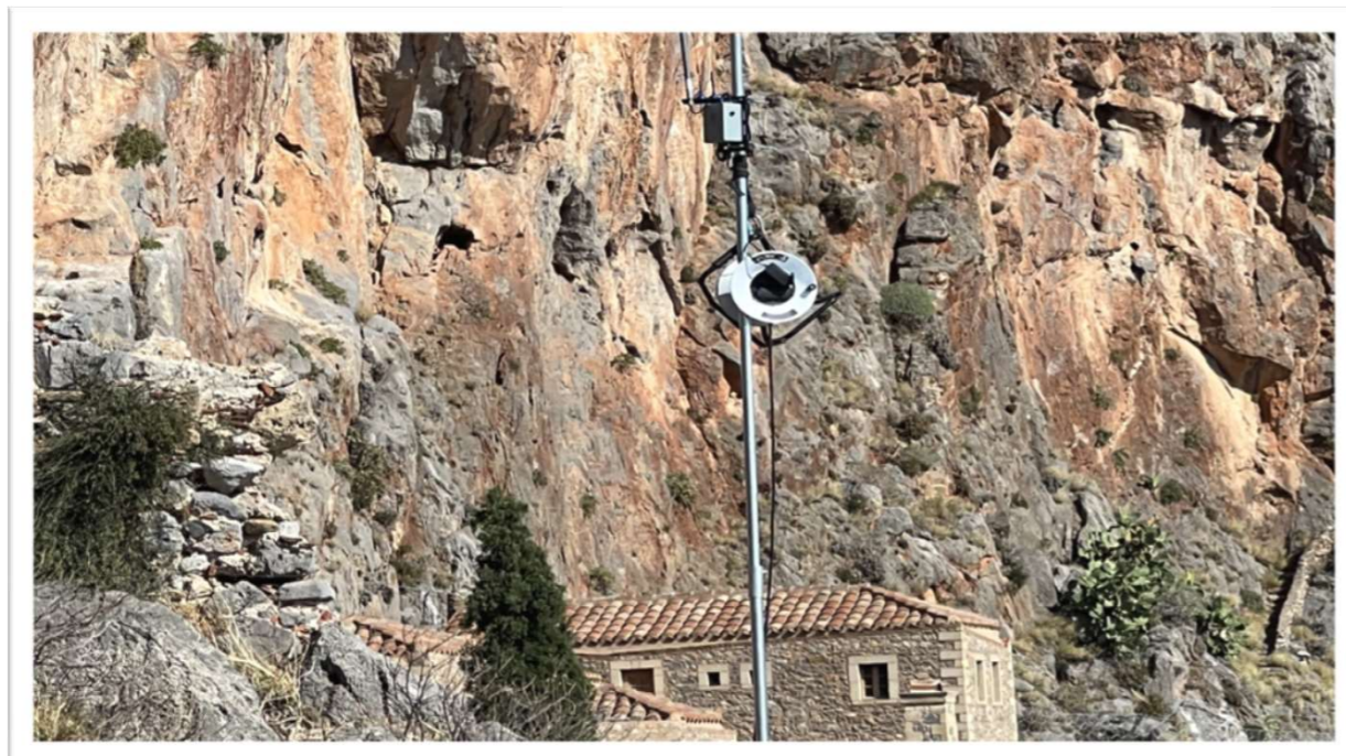
10/2022 | Εγκατάσταση αναμεταδότη δεδομένων τηλεπαρακολούθησης
