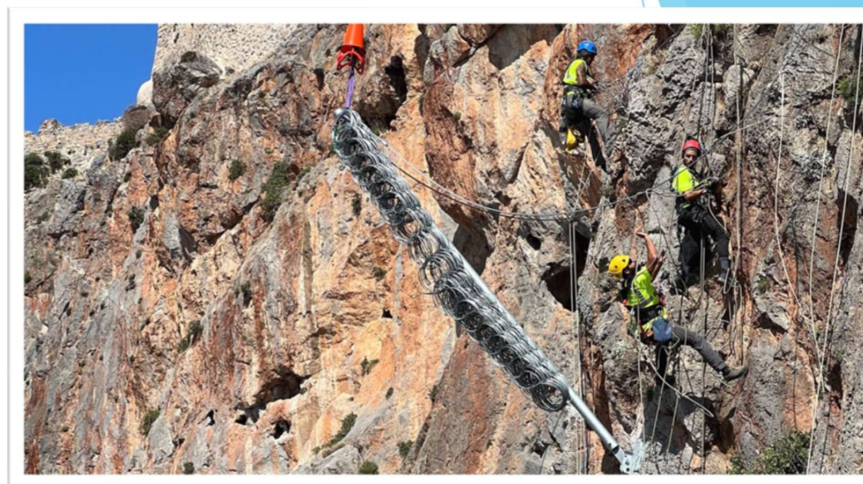
05/2022 | Εγκατάσταση φραχτών ανάσχεσης με χρήση ελικοπτέρου
