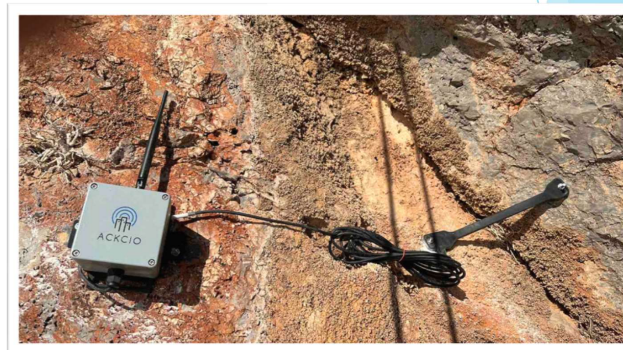
10/2022 | Εγκατάσταση ασύρματου ηλεκτρικού ρωγμόμετρου
