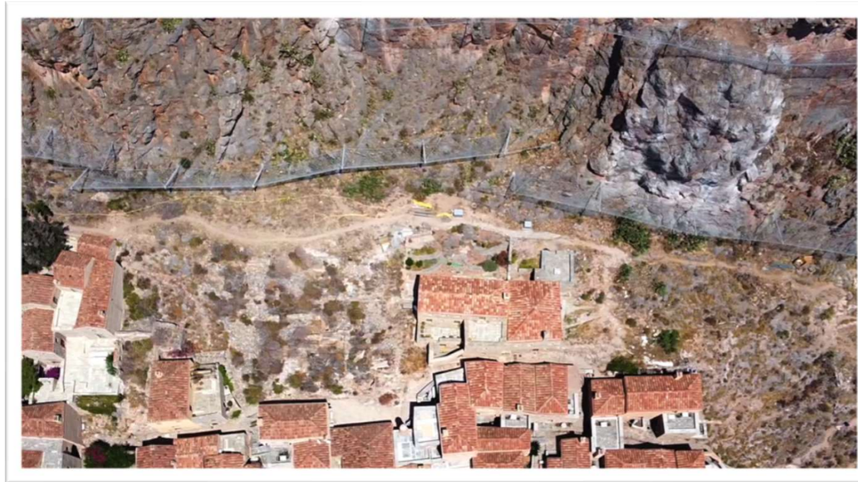
06/2023 | Ολοκλήρωση εργασιών σταθεροποίησης βραχωδών πρανών
