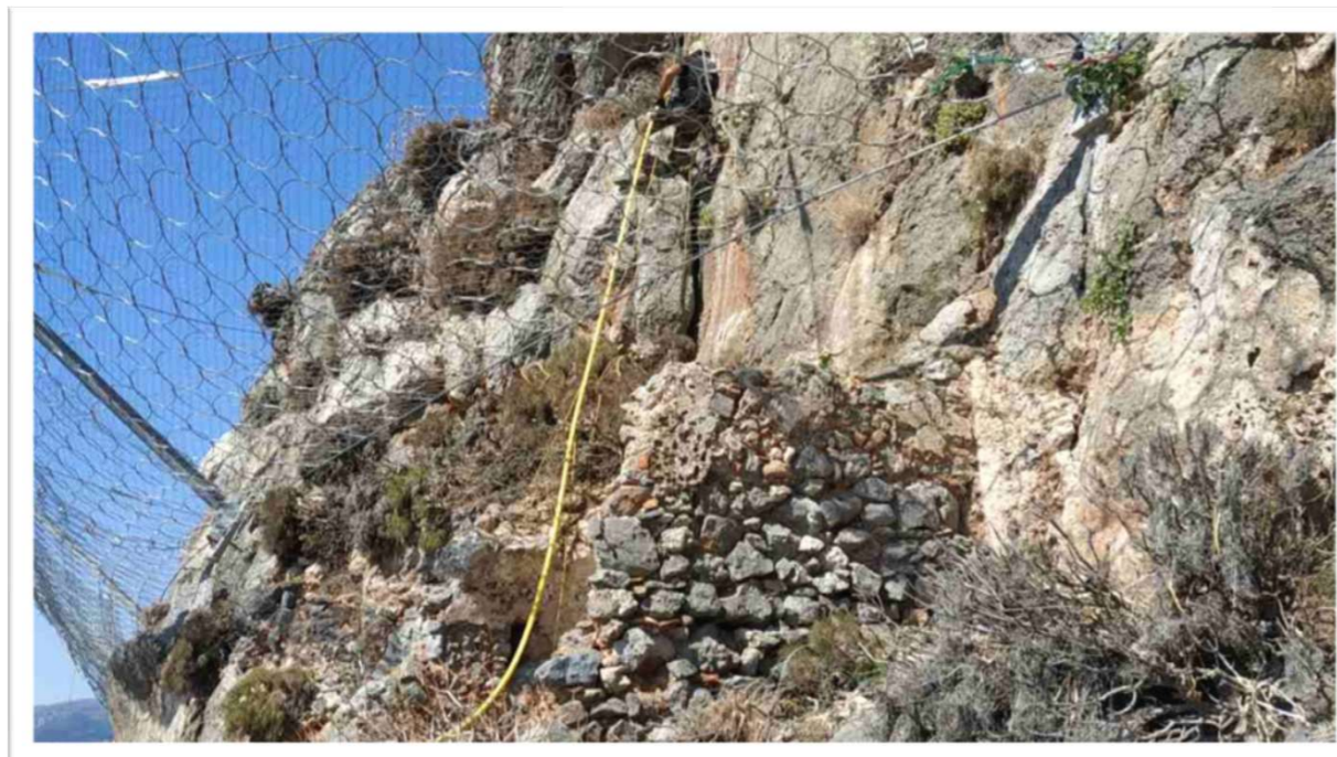
04/2022 | Πλήρωση καρστικών κενών βράχου
