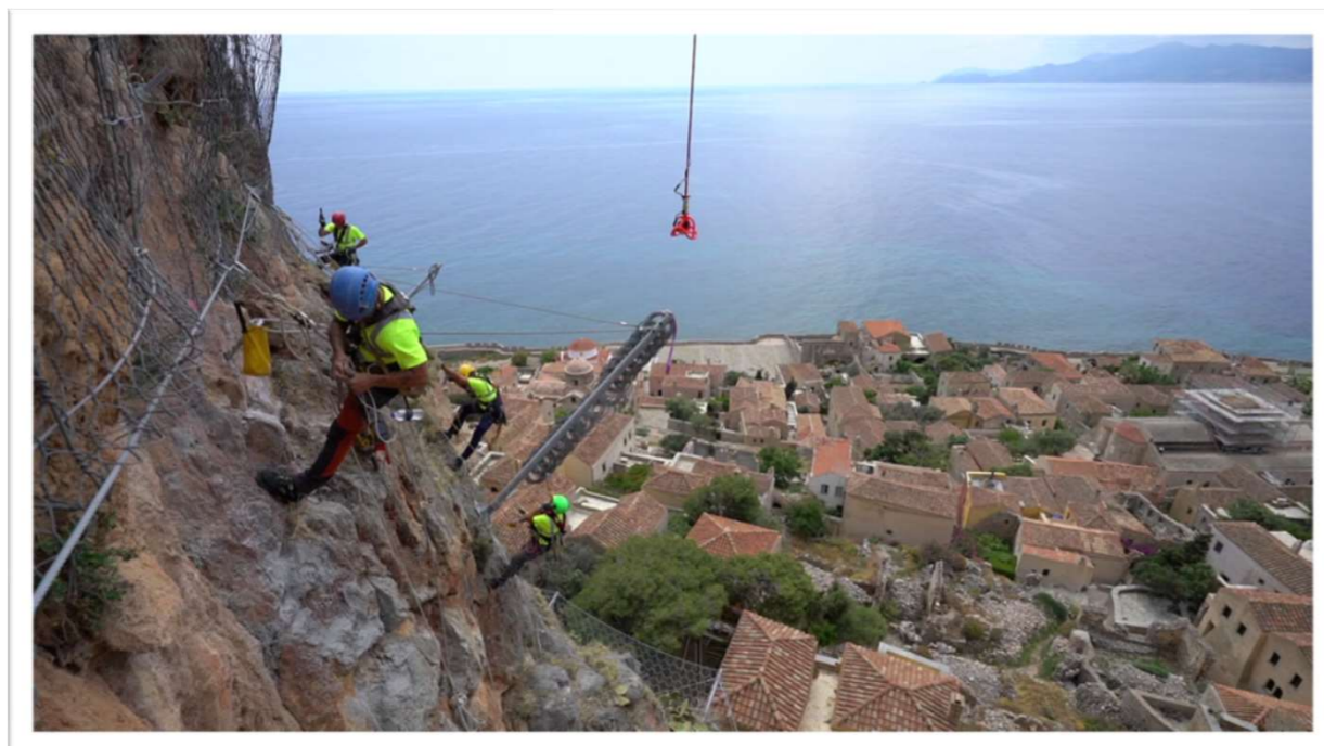
05/2022 | Εγκατάσταση φραχτών ανάσχεσης με χρήση ελικοπτέρου
