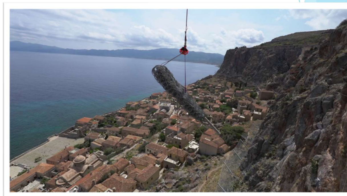
05/2022 | Εγκατάσταση φραχτών ανάσχεσης με χρήση ελικοπτέρου
