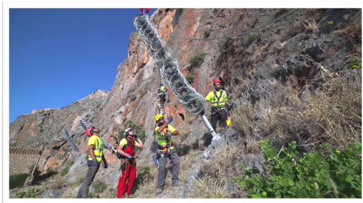
05/2022 | Εγκατάσταση φραχτών ανάσχεσης με χρήση ελικοπτέρου
