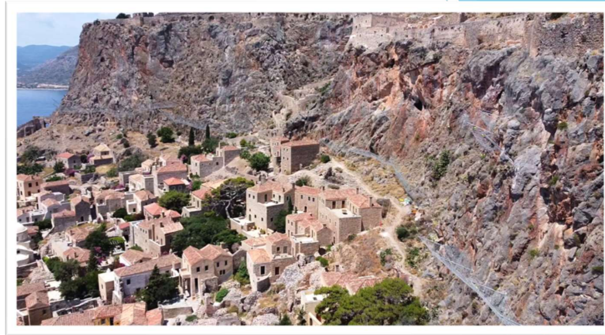
06/2023 | Ολοκλήρωση εργασιών σταθεροποίησης βραχωδών πρανών
