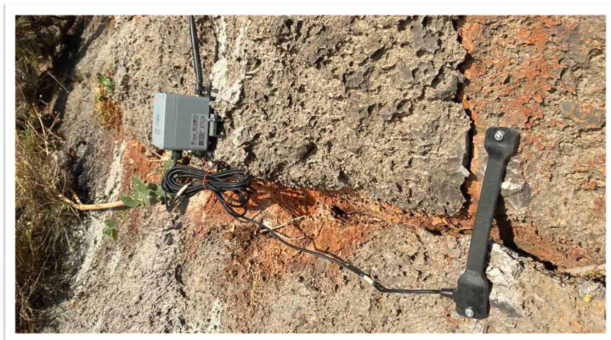
10/2022 | Εγκατάσταση εξοπλισμού ασύρματης τηλεπαρακολούθησης
