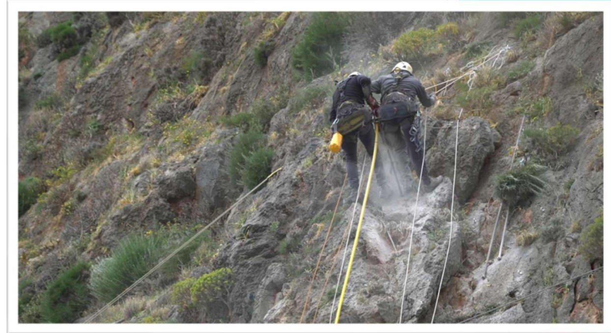
03/2022 | Διατρήσεις βράχων - εγκατάσταση αγκυριών
