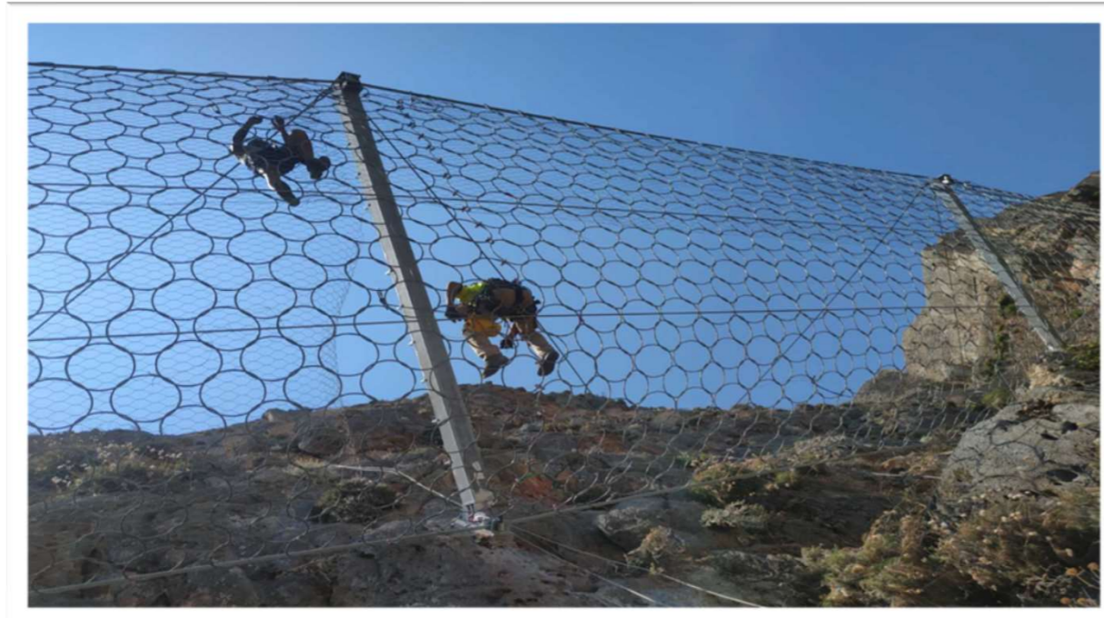
06/2022 | Εγκατάσταση πρόσθετου πλέγματος σε φράχτη ανάσχεσης
