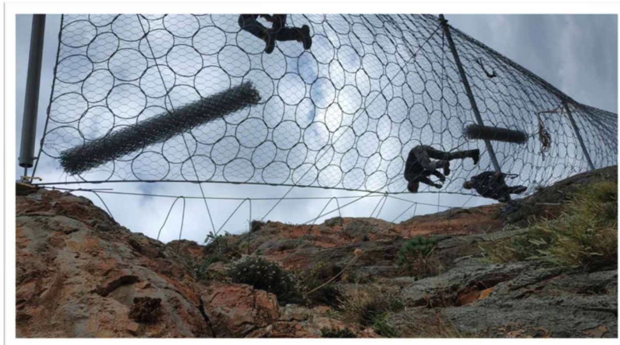
06/2022 | Εγκατάσταση πρόσθετου πλέγματος σε φράχτη ανάσχεσης
