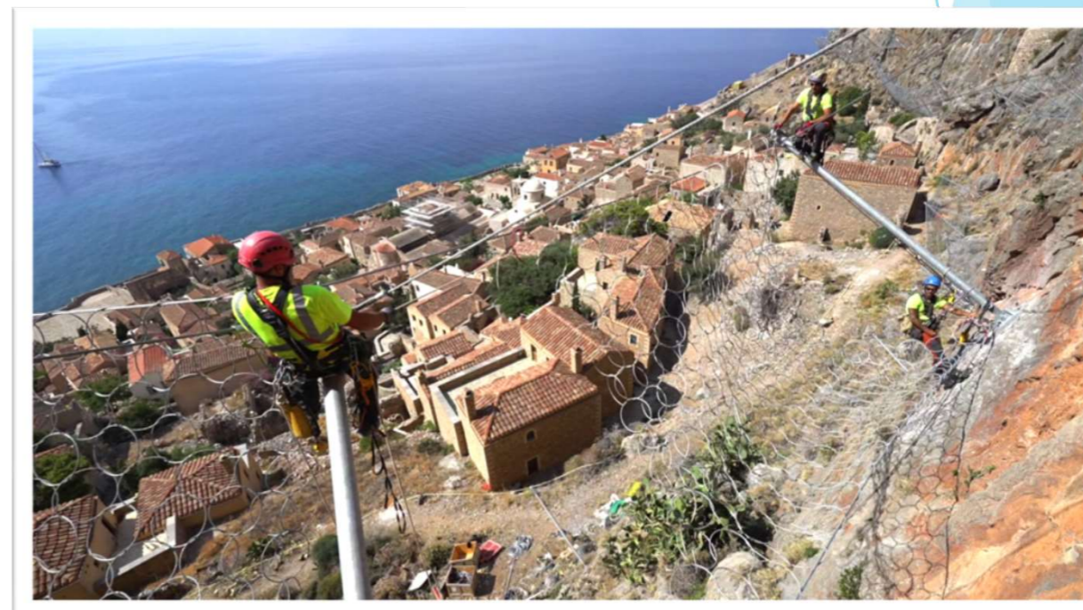
06/2023 | Ανάρτηση - Τάνυση πλέγματος φραχτών ανάσχεσης
