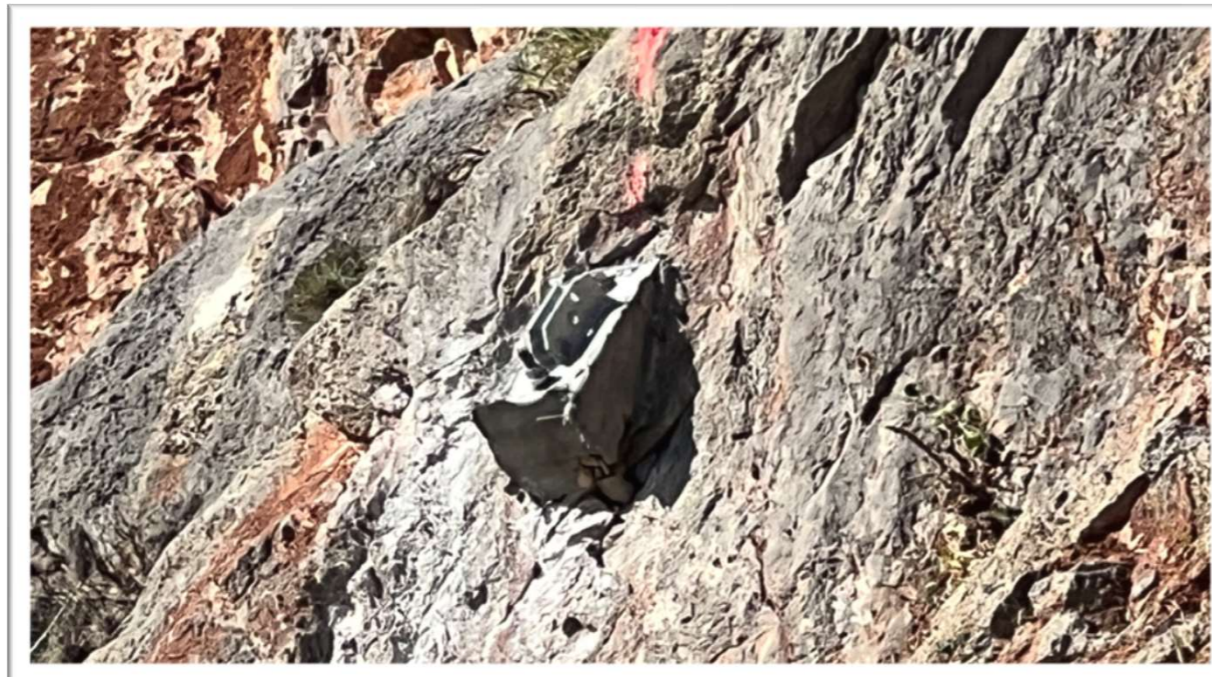
04/2022 | Κατασκευή βάσεων φραχτών ανάσχεσης βραχοπτώσεων
