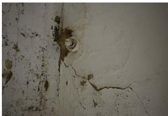
Προβλήματα υγρασίας στον χώρο υγιεινής (Β.09) της νότιας πτέρυγας (προσωπικό αρχείο της Ι. Βομπίρη)
