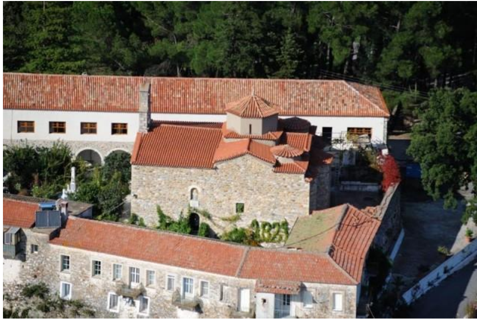
Εικ.100: Άποψη της στέγης του νοτιοανατολικού τμήματος της Μονής, (πηγή: https://immk.gr/wp-content/uploads/2018/07/DSC_3207-640x480.jpg )
