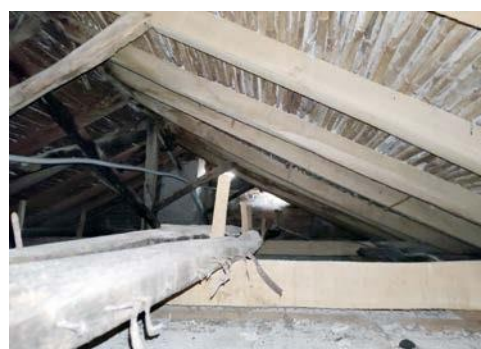
Άποψη του εσωτερικού της κεραμοσκεπής της νότιας πτέρυγας, Φεβρουάριος 2022
