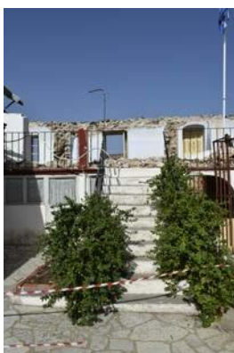
Άποψη της εξωτερικής κλίμακας στη δυτική πτέρυγα νότια πτέρυγα, Σεπτέμβριος 2021 (προσωπικό αρχείο της Ι. Βομπίρη)
