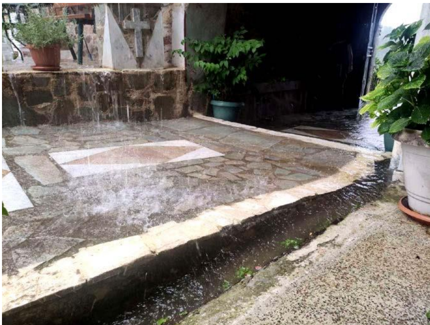
Συσσώρευση λιμναζόντων υδάτων στην είσοδο της Μονής λόγω των υφιστάμενων κλίσεων της μοναστηριακής αυλής, Ιούλιος 2022 (προσωπικό αρχείο της Ι. Βομπίρη)
