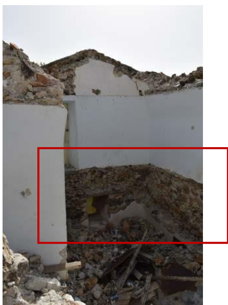
Απώλεια πατώματος στη δυτική πτέρυγα, Σεπτέμβριος 2022 (προσωπικό αρχείο της Ι. Βομπίρη)
