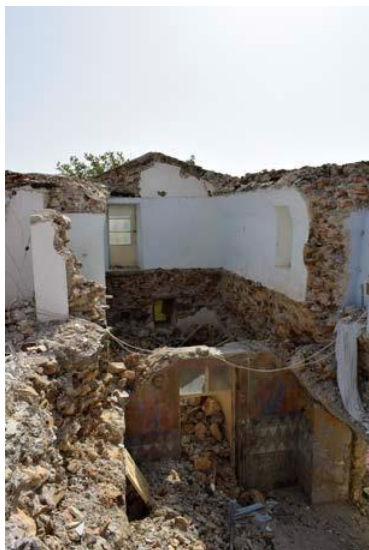
Άποψη των καταρρεύσεων στη ΝΔ γωνία της δυτικής με δυτικής πτέρυγας, Σεπτέμβριος 2021 (προσωπικό αρχείο της Ι. Βομπίρη)
