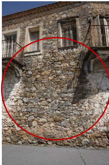
Τοιχοποιία νότιας εξωτερικής όψης, Σεπτέμβριος 2021 (προσωπικό αρχείο της. Ι. Βομπίρη)
