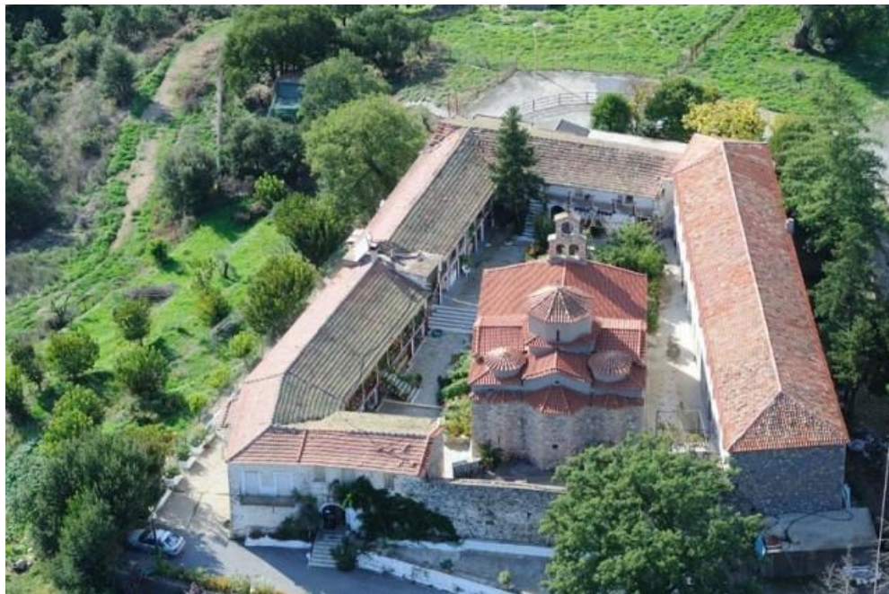
Συνολική άποψη των στεγών όλων των πτερύγων της Μονής πριν τις καταρρεύσεις στη δυτική πτέρυγα
