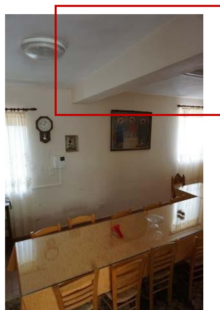
Άποψη δοκού από σπλισμένο σκυρόδεμα στο χώρο της τραπεζαρίας, για τη στήριξη του πατώματος του ορόφου (προσωπικό αρχείο της Ι. Βομπίρη)
